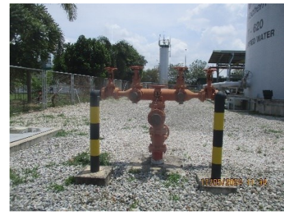
หัวจ่ายน้ำดับเพลิง (Fire Hydrant)
