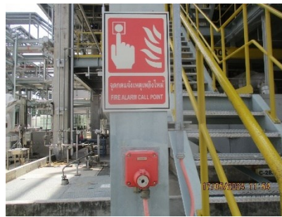
สัญญาณเตือนภัย (Fire Alarm)
