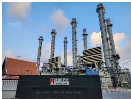
ภาพที่ 2.2-2 โรงงานที่มีการปล่อยมลพิษทางอากาศต้องก่อสร้างปล่องสูงไม่น้อยกว่า 60 ม.
