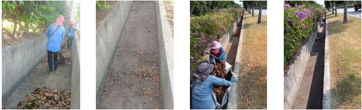
ภาพที่ 2.2-14 การทำความสะอาดและลอกตะกอนในรางระบายน้ำฝนในพื้นที่นิคมฯ
