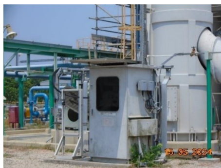
ภาพที่ 2.2-4 อุปกรณ์ตรวจสอบคุณภาพอากาศจากปล่อง แบบอัตโนมัติ (CEMS) ของโรงงาน
