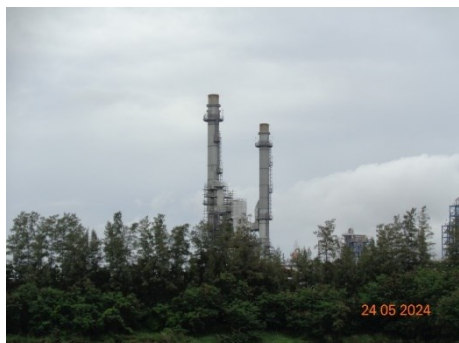
ภาพที่ 2.2-2 โรงงานที่มีการปล่อยมลพิษทางอากาศต้องก่อสร้างปล่องสูงไม่น้อยกว่า 60 ม.
