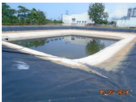
ภาพที่ 2.2-6 บ่อพักน้ำเสียภายในโรงงาน (Holding Pond)
