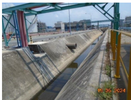
ภาพที่ 2.2-7 รางระบายน้ำฝนภายในโรงงาน
