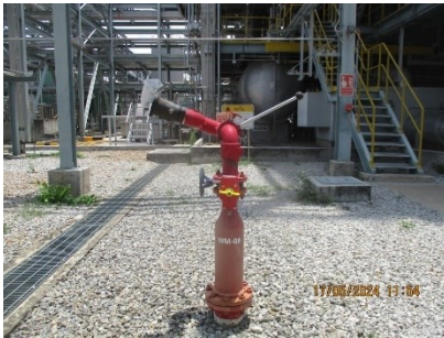
แท่นหัวฉีดน้ำดับเพลิง (Fire Monitor)
